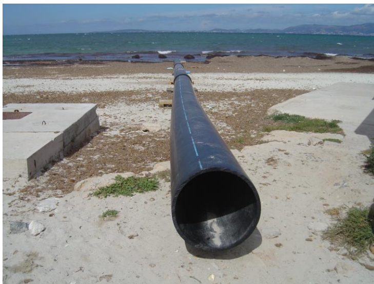
Imatge 10. Emissari dipositat a la platja abans de ser connectat i enterrat.
