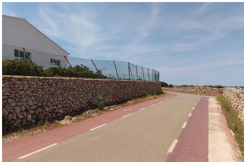
FIGURA 26. VISTA DES DE LA CARRETERA CF-5 FONT: PRÒPIA
