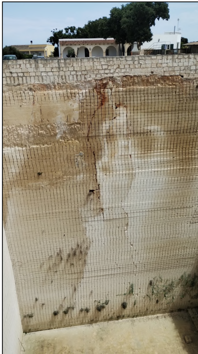
Vista general del talud AB
