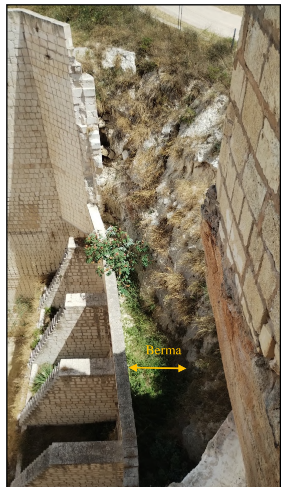
Vista lateral de la misma zona.
