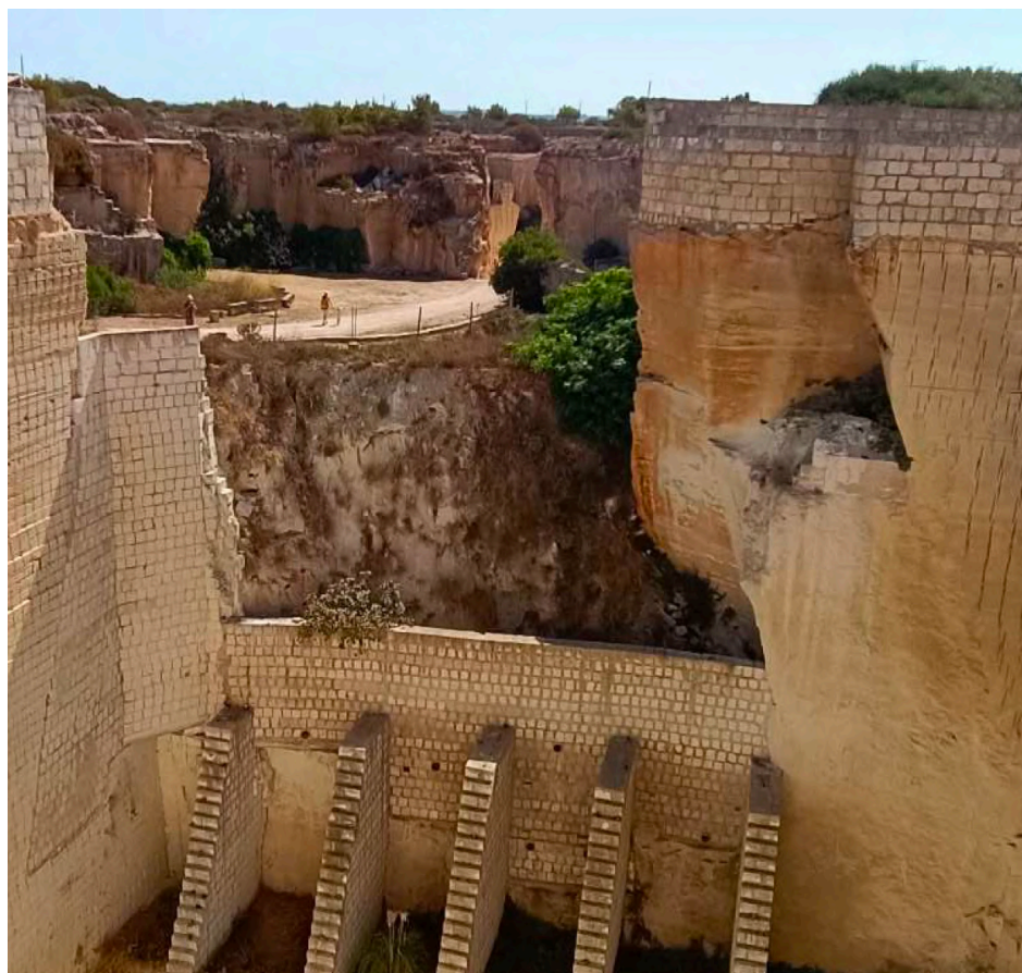
Fig. 32. Zona del talud a consolidar
