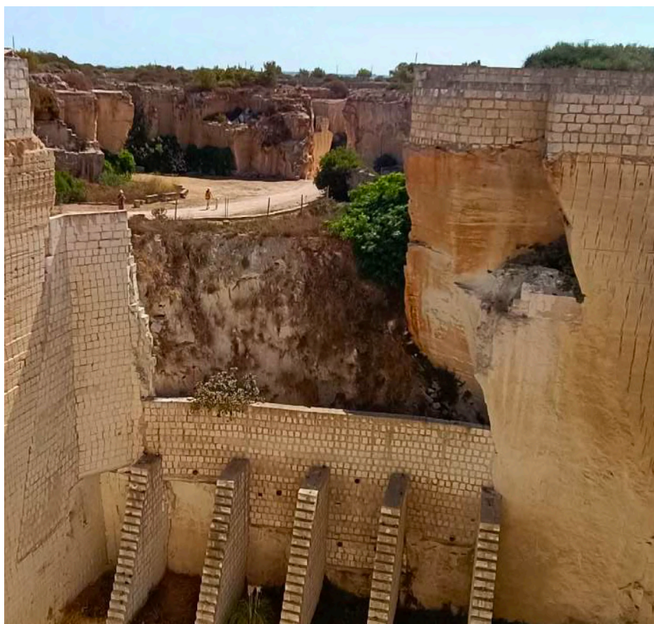
Fig. 13. Zona del talud a consolidar
