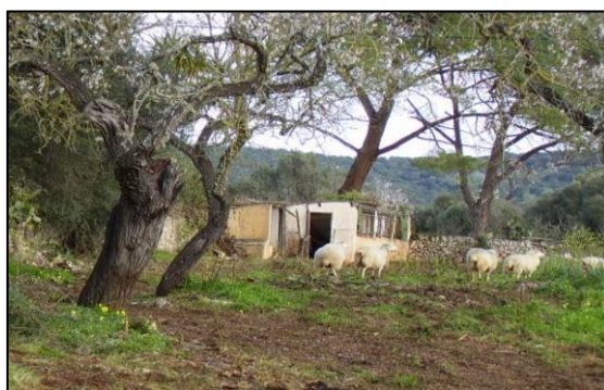
IMAGEN 7. ESTADO ACTUAL DE LA EDIFICACIÓN 7
