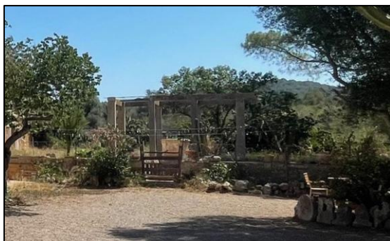
IMAGEN 8. ESTADO ACTUAL ALJIBE 1.
