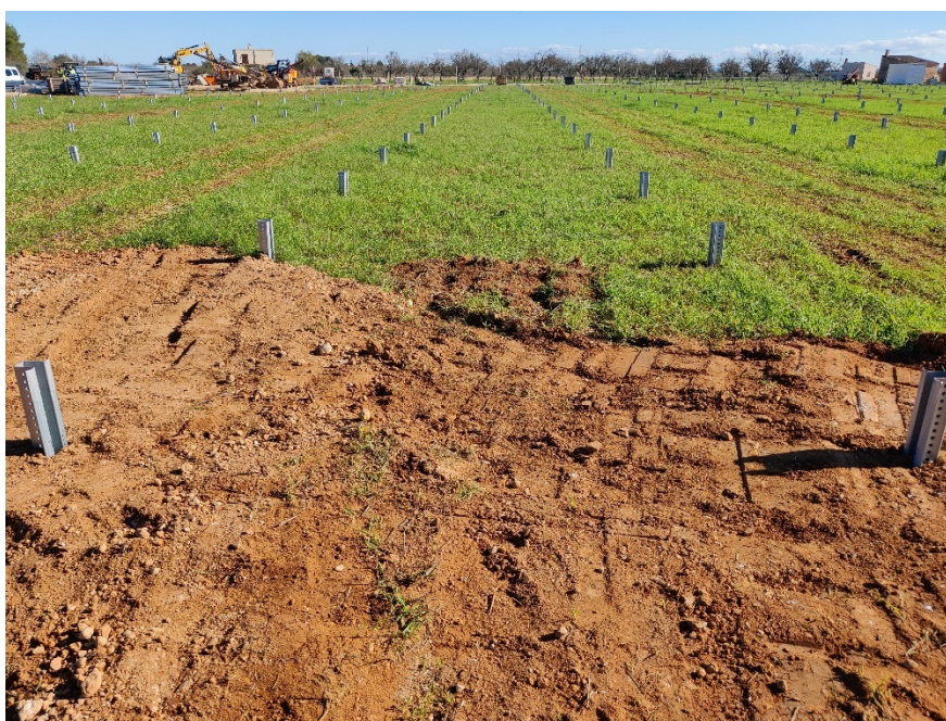
Hincado de soportes de acero galvanizado en el parque solar fotovoltaico Can Fuster (Santa Maria del Camí).
