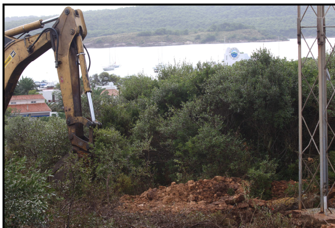
Figura 7: Obres per substitució torreta S15
