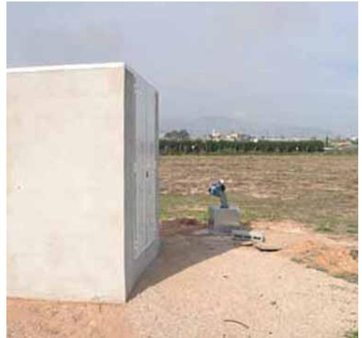
*Bomba de extracción de agua subterránea y caseta con los controles eléctricos.*
