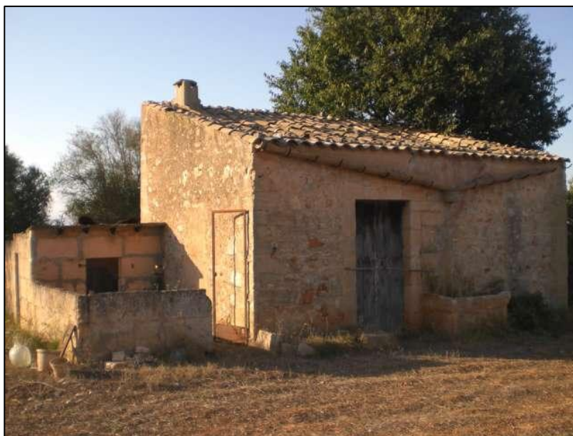
ILUSTRACIÓN 8 EJEMPLO DE CONSTRUCCIÓN TRADICIONAL
