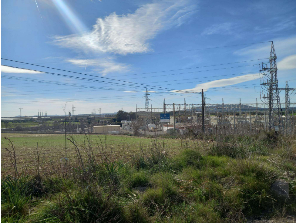
Figura 20. Subestación Es Bessons vista desde la carretera Ma - 3320.
