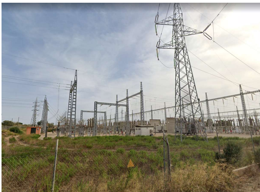
Figura 55. Vista actual de la SE con pórtico existente
