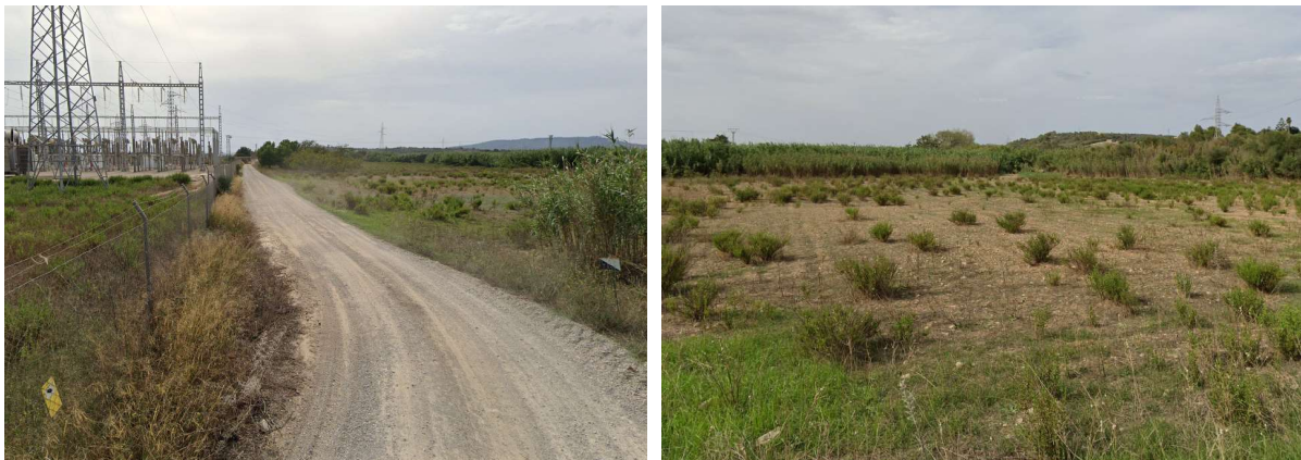
Figura 57. Vía de comunicación pública (izq.) y terrenos del apoyo T-46N (der.)
