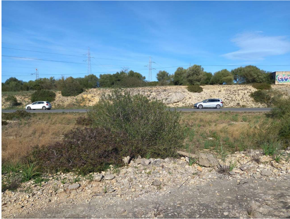
Figura 13. Vista carretera Ma-3320 desde la SE
