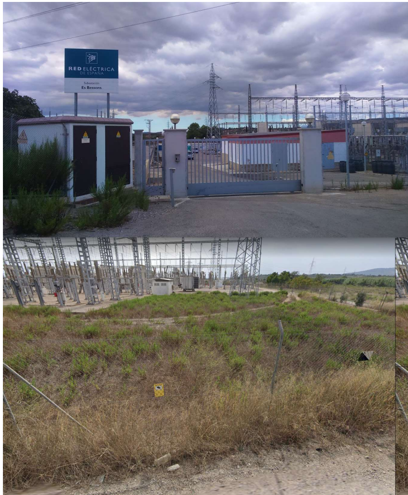
Figura 49. Entrada a la Subestación Es Bessons (arriba) y Terrenos a ocupar por la ampliación (abajo)
