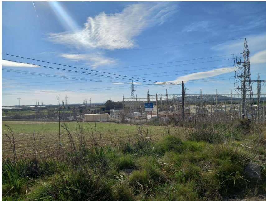
Figura 11. Subestación Es Bessons, vista desde carretera Ma-3320
