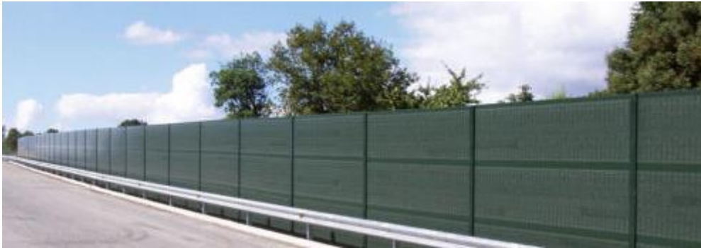
Figura 7.2.4.2.1. Ejemplo de barrera acústica Fuente: ACH
