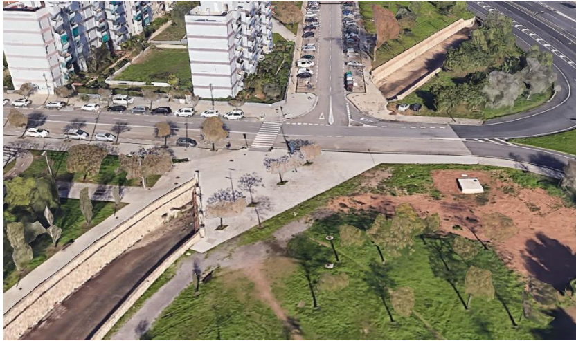
Figura 3.4.1.2.1. Canal/acequia identificada por donde se prevé un cruzamiento con la infraestructura de evacuación de todas las alternativas en la zona más cercana a la subestación (X: 472.198; Y: 4.379.857). La infraestructura de evacuación seguirá el trazado de la carretera existente de manera que en este cruzamiento discurra adosada a la misma, no previéndose afección sobre este torrente y canal
