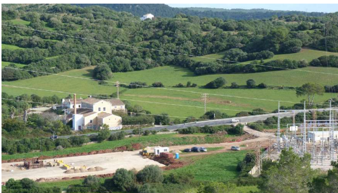
Antigua harinera S'Arangí al otro largo del margen de la carretera Me-1. En primer plano, obras de la nueva subestación elevadora 20/132 kV
