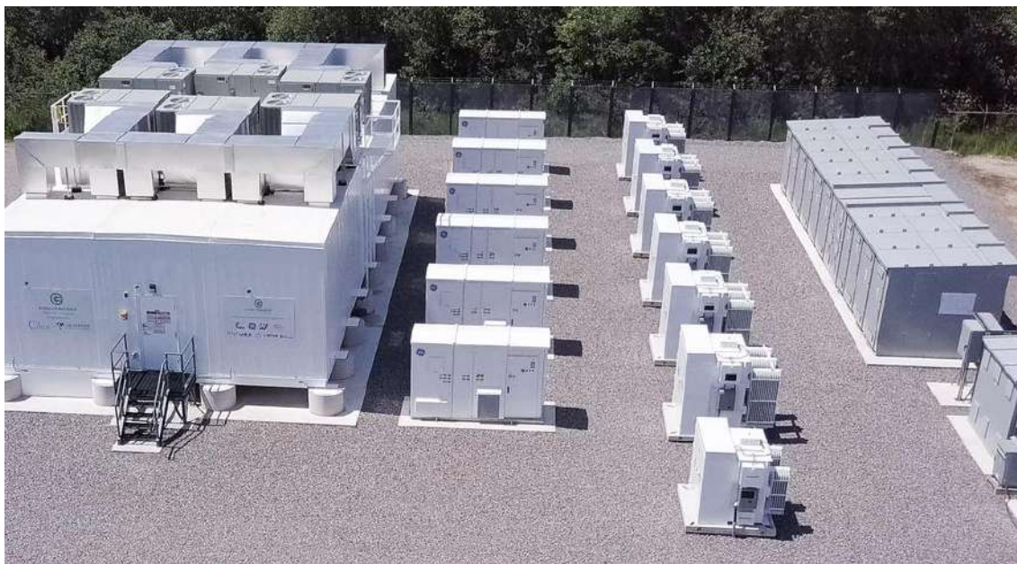
Ejemplo de módulo de almacenamiento de eStorage- Flex 10 de ABB
