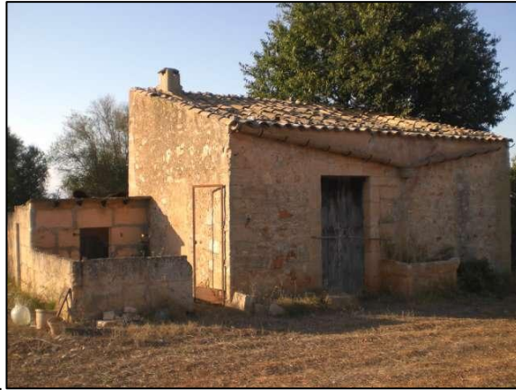
ILUSTRACIÓN 7 EJEMPLO DE CONSTRUCCIÓN TRADICIONAL
