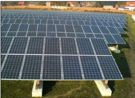
Fotografía 1. Sistema mediante ríostros o bases de hormigón prefabricadas.
