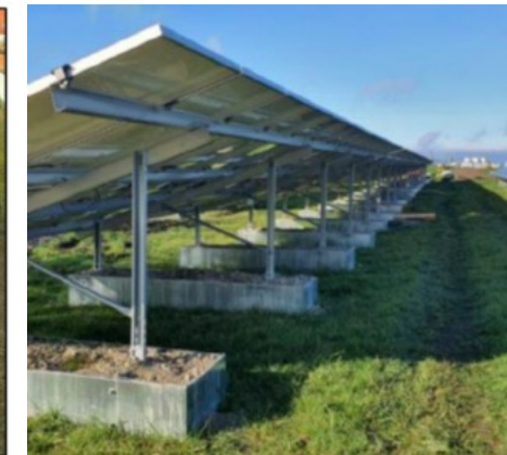
Fotografía 1. Sistema mediante riostras o bases de hormigón prefabricadas.
