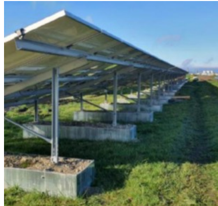
Fotografía 1. Sistema mediante ríostros o bases de hormigón prefabricadas.
