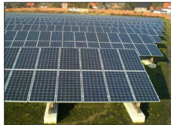
Fotografía 1. Sistema mediante riostras o bases de hormigón prefabricadas.
