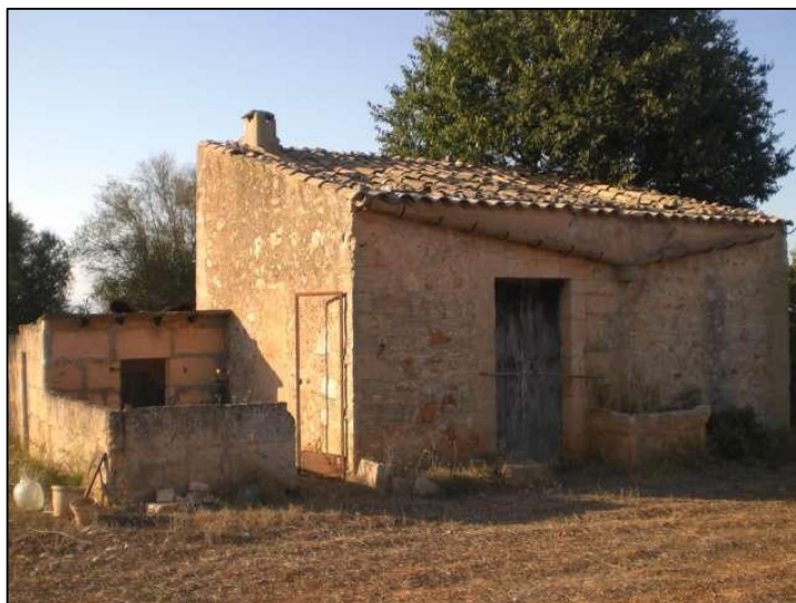
ILUSTRACIÓN 9 EJEMPLO DE CONSTRUCCIÓN TRADICIONAL
