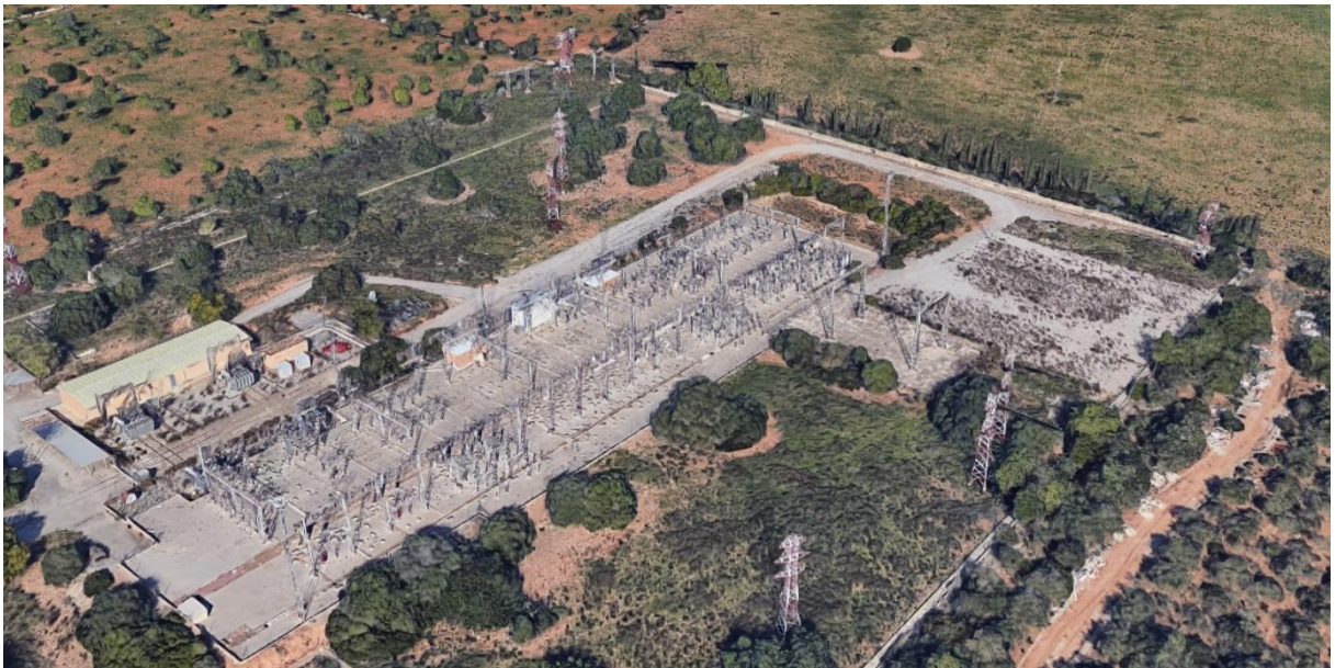
Ejemplo de subestación eléctrica: Marratxí
