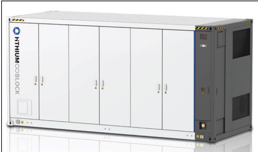
Imagen 9: Container de baterías.
