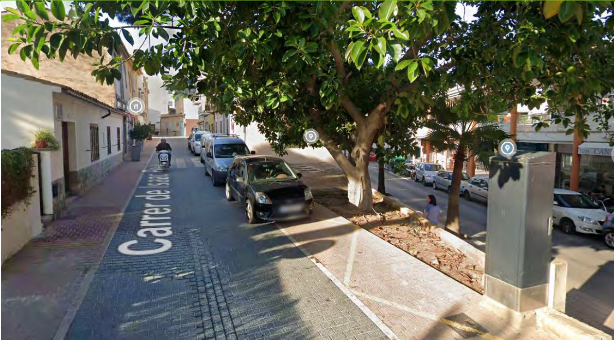
Foto2. Calle De Isaac Peral donde conectará con el CT14572 y LSMT por acera.
