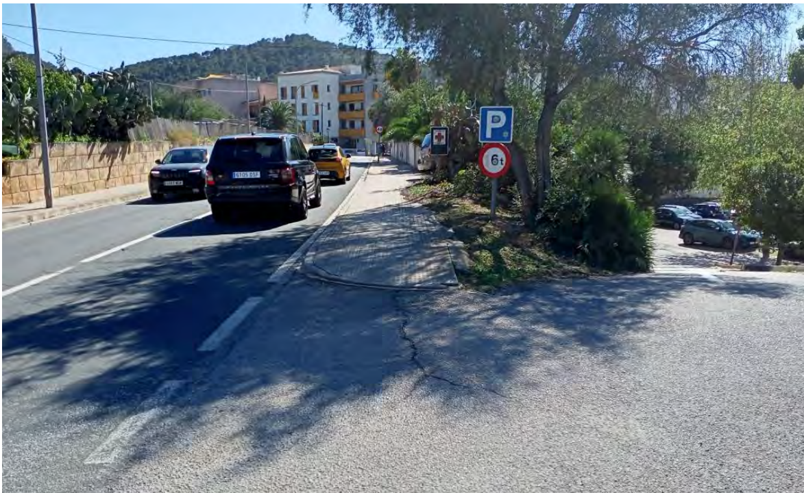
Foto2. Acera por donde pasará la nueva LSMT
