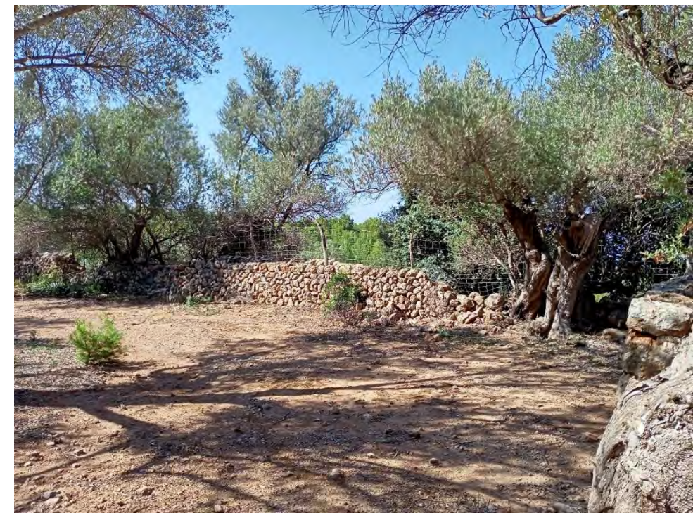
Foto6. Zona per on passarà la nova rasa subterrània
