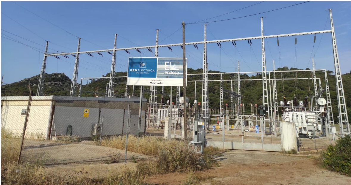
Fotografía 1: Diferentes vistas de las parcelas afectadas por el presente proyecto de infraestructura y SET Mercadal en las proximidades de las mismas.
