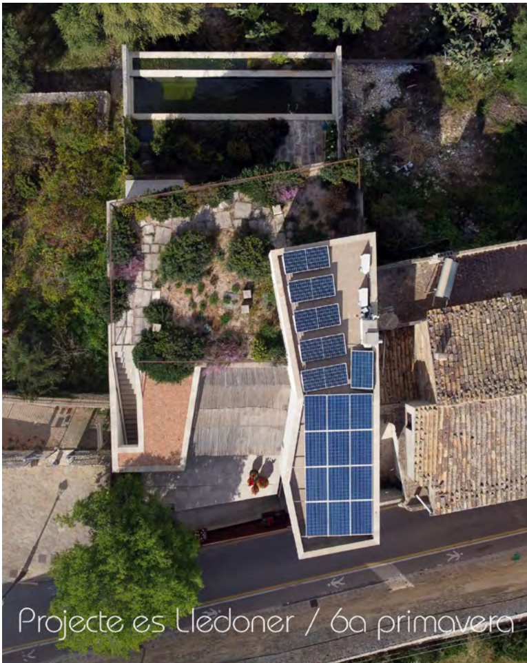
Figura 25. Cubierta de vivienda familiar entre medianeras que combina techo verde y producción de energía solar. Proyecto Es Lledoner, Inca. Arquitecto Jaume Lluís Salas. Fuente: MARES Arquitectura, Paisatge i Territori. https://www.m-ar.es/
