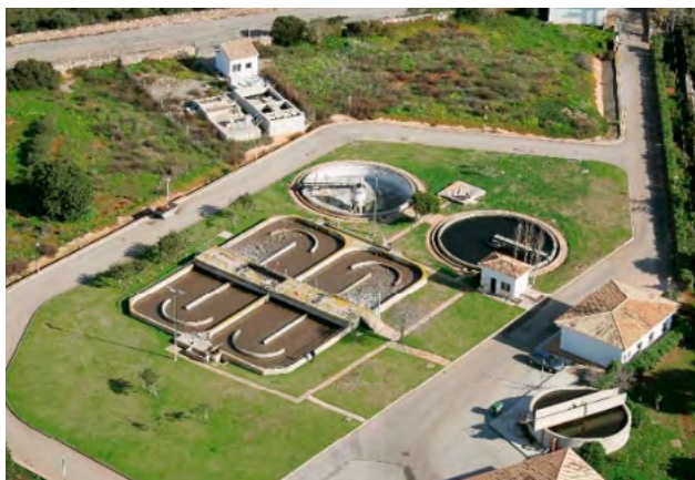
Figura 13: EDAR de Portocolom Fuente: Gobierno de las Illes Balears
