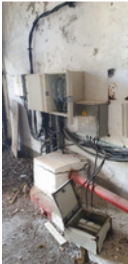
Instal·lacions elèctriques en mal estat.
