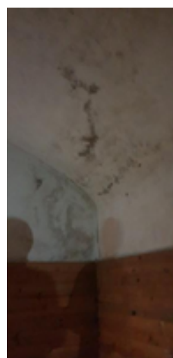
Interior de les sales annexes al túnel, recobertes de fusta fins a la meitat. S'aprecien taques d'humitat a la fusta i sostre.
