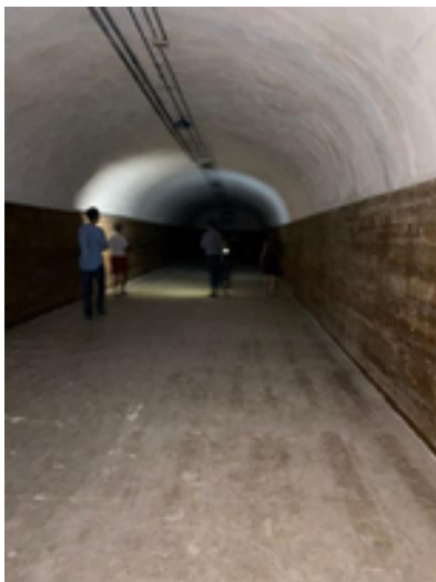
Interior de les sales annexes al túnel, recobertes de fusta fins a la meitat. S'aprecien taques d'humitat a la fusta i sostre.
