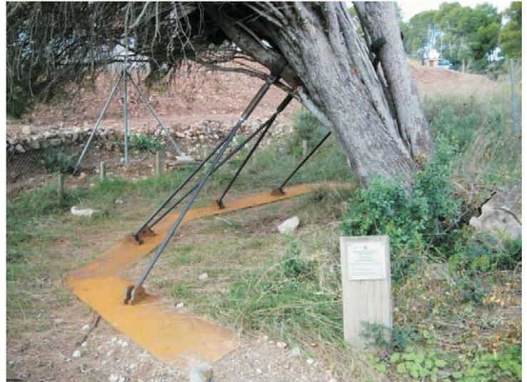
**foto: Sistema de reforç a un arbre singular. Arxiu SPE.**
