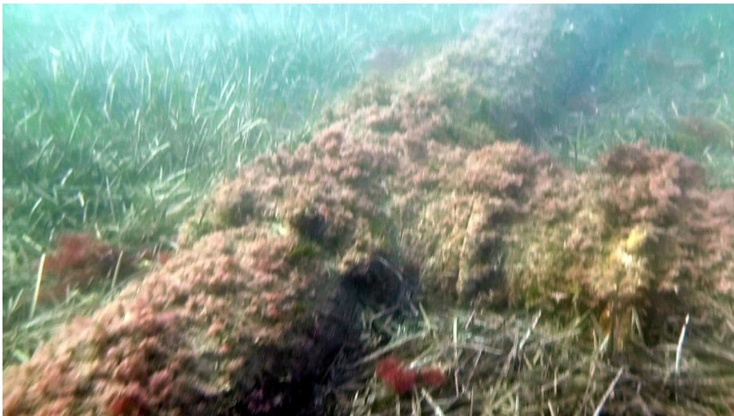
Al llegar al tramo difusor el emisario se bifurca en T y después cada uno de los brazos forma una H, en cuyos 4 extremos se insertan codos que sitúan las 8 bocas difusoras elevadas del fondo aproximadamente 1 m. Esta estructura se encuentra anclada mediante muertos de hormigón en forma de U invertida.
