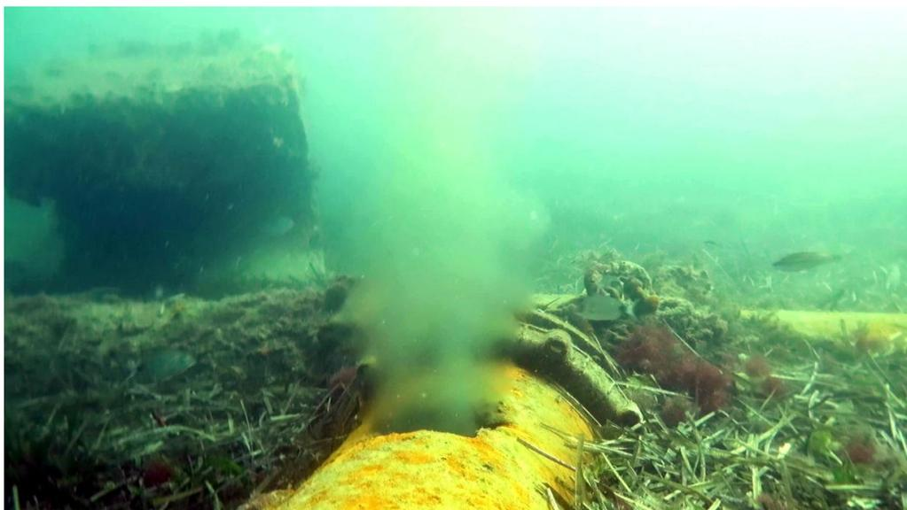
La integridad general del emisario inspeccionado parece correcta. Solamente se han localizado algunos de los lastres de anclaje fuera de su posición original, volcados y separados de la conducción, y una rotura muy próxima al tramo difusor, por el que se escapa parte del efluente.
