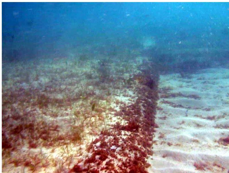
La tubería discurre a partir de aquí por una zanja excavada en el fondo, de una anchura variable pero del orden de los 10m y una altura de talud media de 2 m. La zanja se excavó en una superficie ocupada por un fondo mixto de algas fotófilas y *Posidonia oceanica* sobre roca en su mitad más cercana a la costa, y sobre pradera de *Posidonia oceanica* en su mitad más alejada de la orilla.
