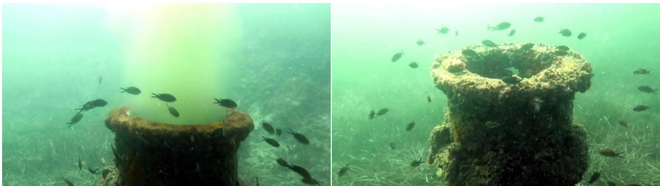
La integridad general del emisario inspeccionado parece correcta. Solamente se han localizado algunos de los lastres de anclaje fuera de su posición original, volcados y separados de la conducción, y una rotura muy próxima al tramo difusor, por el que se escapa parte del efluente.
